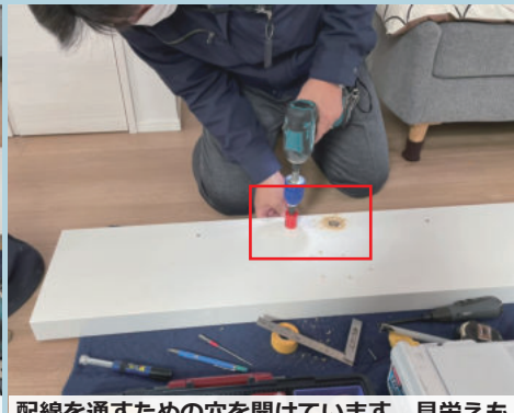
配線を通すための穴を開けています。見栄えも良く、線同士の絡まり防止で一石二鳥！
