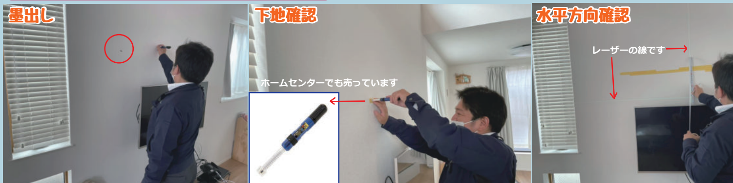
墨出し まずは墨出しをします。棚の取り付け位置を決め写真のように下書きをしていきます。
