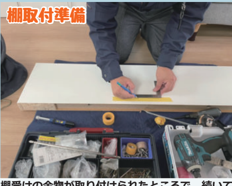
棚取付準備 棚受けの金物が取り付けられたところで、続いて棚を取り付けていきます。
